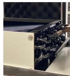
E-Coating на контуре теплообменников
